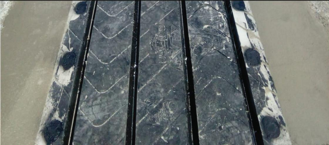
I giunti di dilatazione sono stati ideati per garantire la continuità tra due elementi strutturali separati tra loro e per assecondare gli spostamenti delle strutture stesse.
